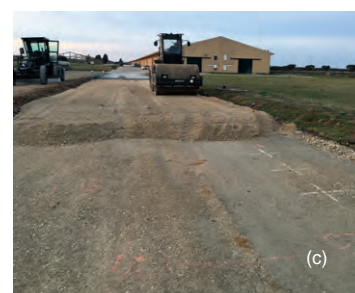
Figura 4. Produção das MTC em central (a), pormenor de MTC com FC (b) e compactação da camada de base (c)
