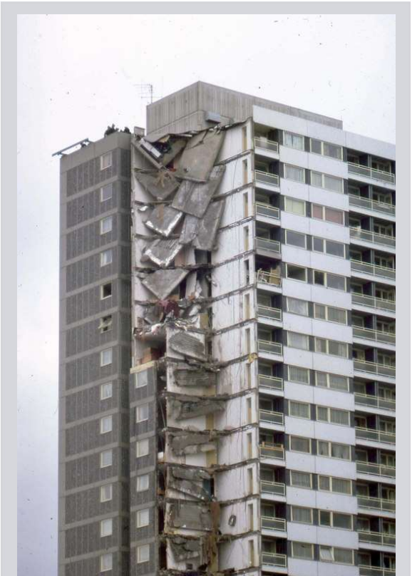
Colapso edifício de habitação social pré-fabricado – Ronan Point – 1968 – Londres
